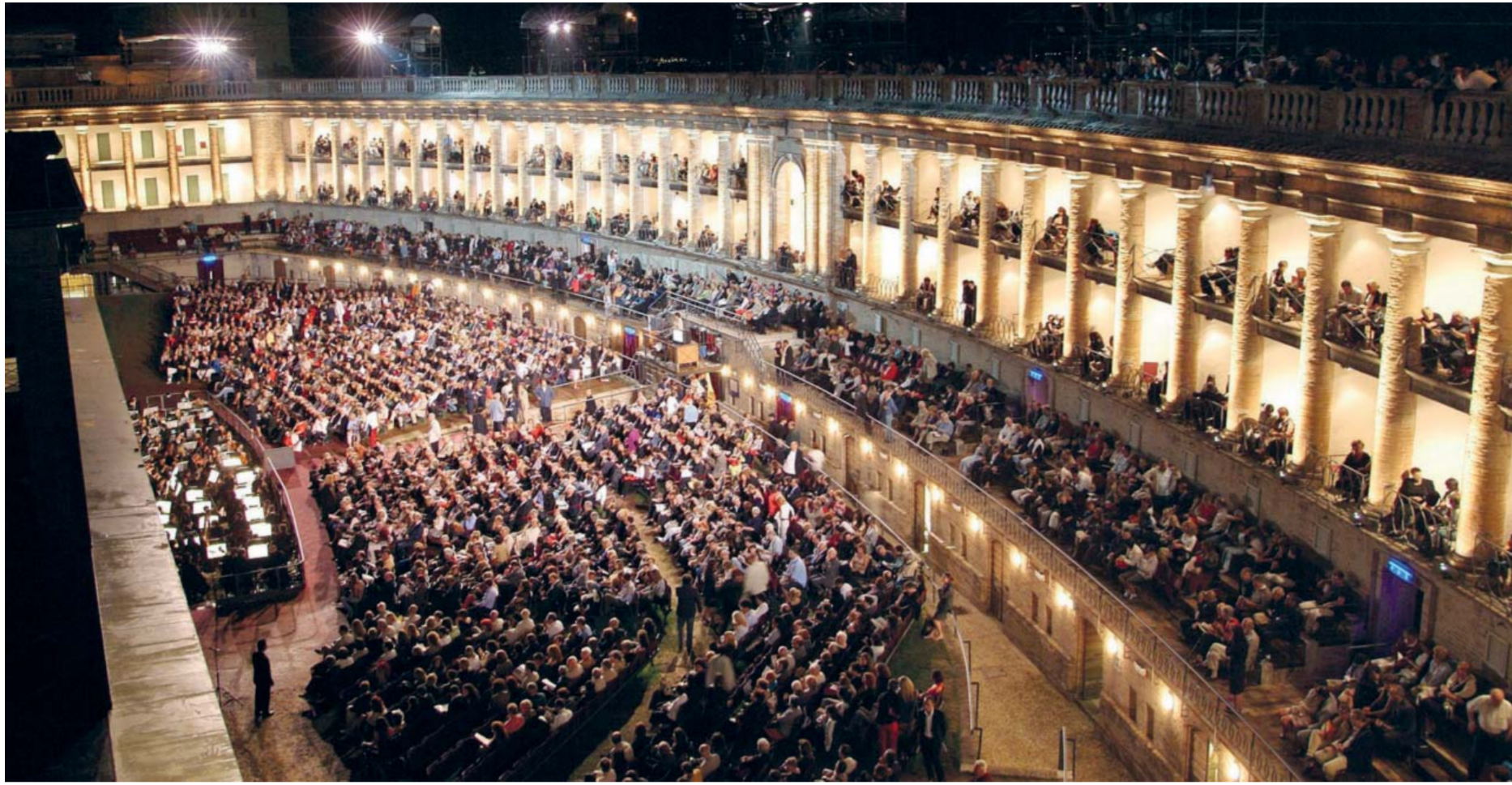
Lo Sferisterio di Macerata. È una struttura teatrale unica nel suo genere architettonico (capienza 2.800 posti). Secondo i più noti cantanti lirici è il teatro all'aperto con la migliore acustica in Italia
